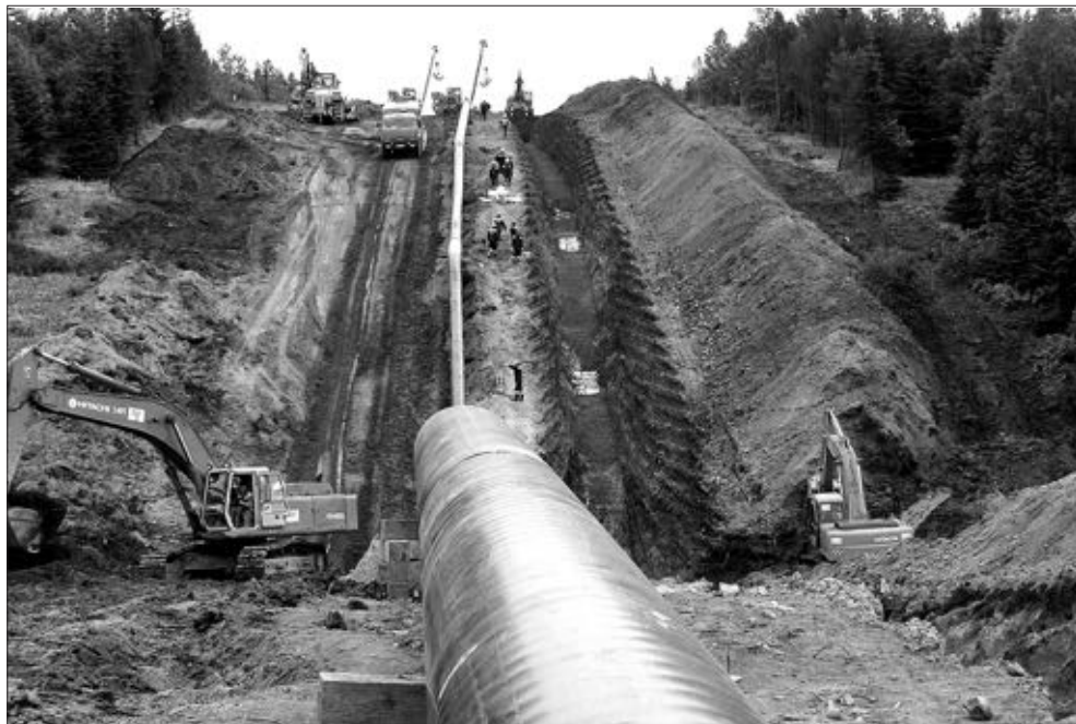
Рисунок 7.1. Строительство линейной магистрали наземного трубопровода
