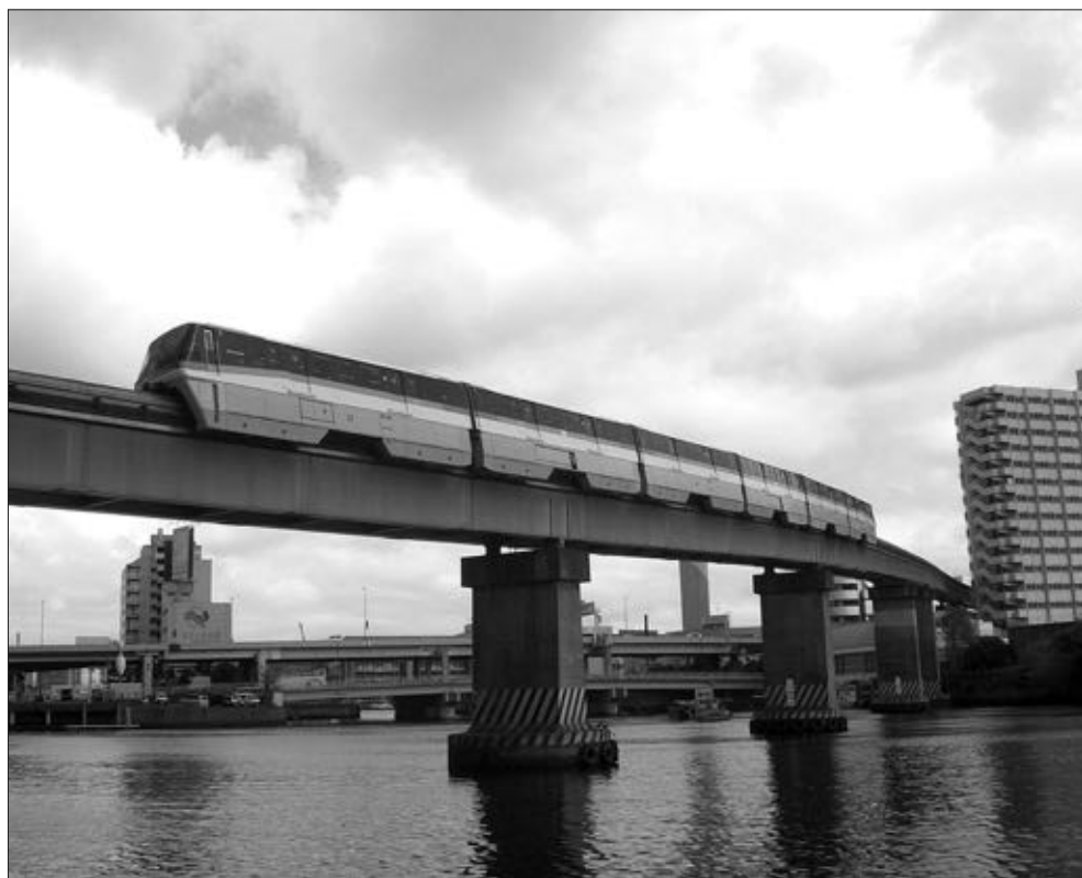
Рисунок 10.4. Монорельсовая дорога, Токио, Япония
